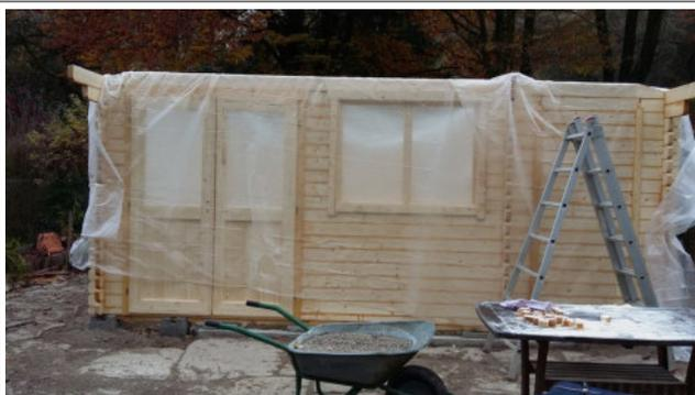
Steht nun das Fundament, geht der restliche Aufbau des Hauses relativ schnell. Alles basiert auf einer Nut-Feder-Konstruktion und muss lediglich richtig zusammengesteckt werden.
