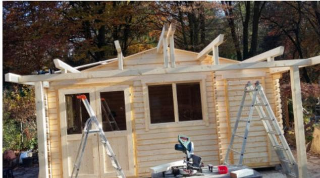
Die Konstruktion für das Vordach entsteht.
