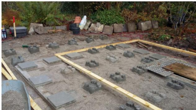
Auslegen des Fundaments. Bei uns kamen Betonfundamentsteine zum Gebrauch, da wir das Haus mit einem Abstand zum Boden gebaut haben.
